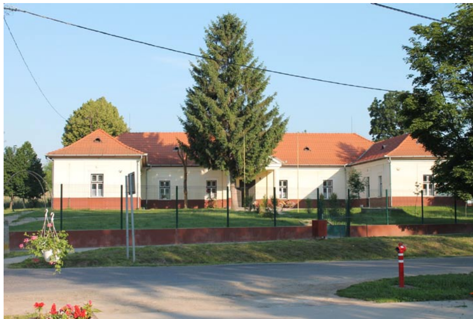
A Bénye-kávai Puky-kúria, jelenleg általános iskola
